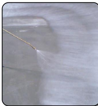
COMPUESTOS PARA CURACIÓN DE CONCRETO
